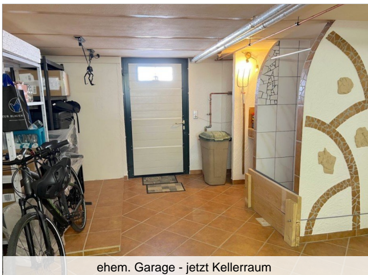
Kellerraum mit Heiztechnik
